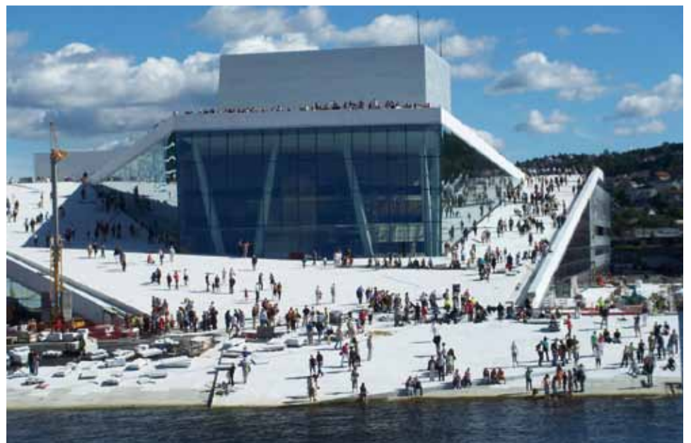
New Opera House in Oslo, Norwegen (Architekten Snohetta AS)
